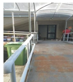
Ingresso Vano scala posteriore C
