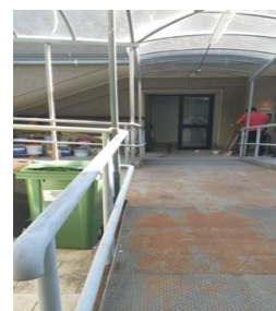
Ingresso Vano scala posteriore C
