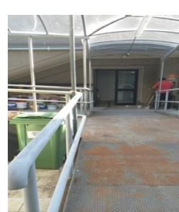
Ingresso Vano scala posteriore C
